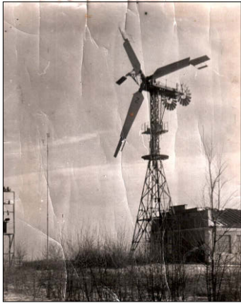
Вітроелектростанція проф. В.Н. Андріанова
