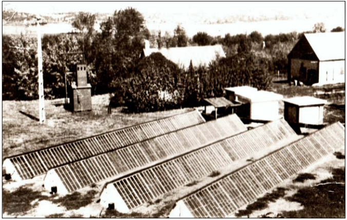
Камерна сушарка з додатковими сонячними підігрівачами
