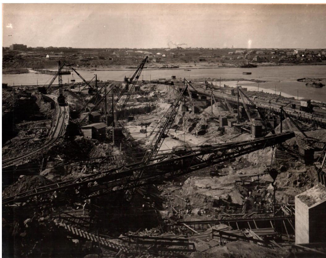
Фото. Будівництво лівобережної частини греблі. 22.07.1929 р. Фотоальбом «Днепрострой» і «Днепрозаводстрой». м. Запоріжжя.
